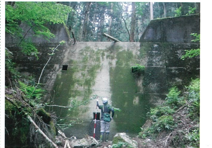
▲治山施設点検調査
