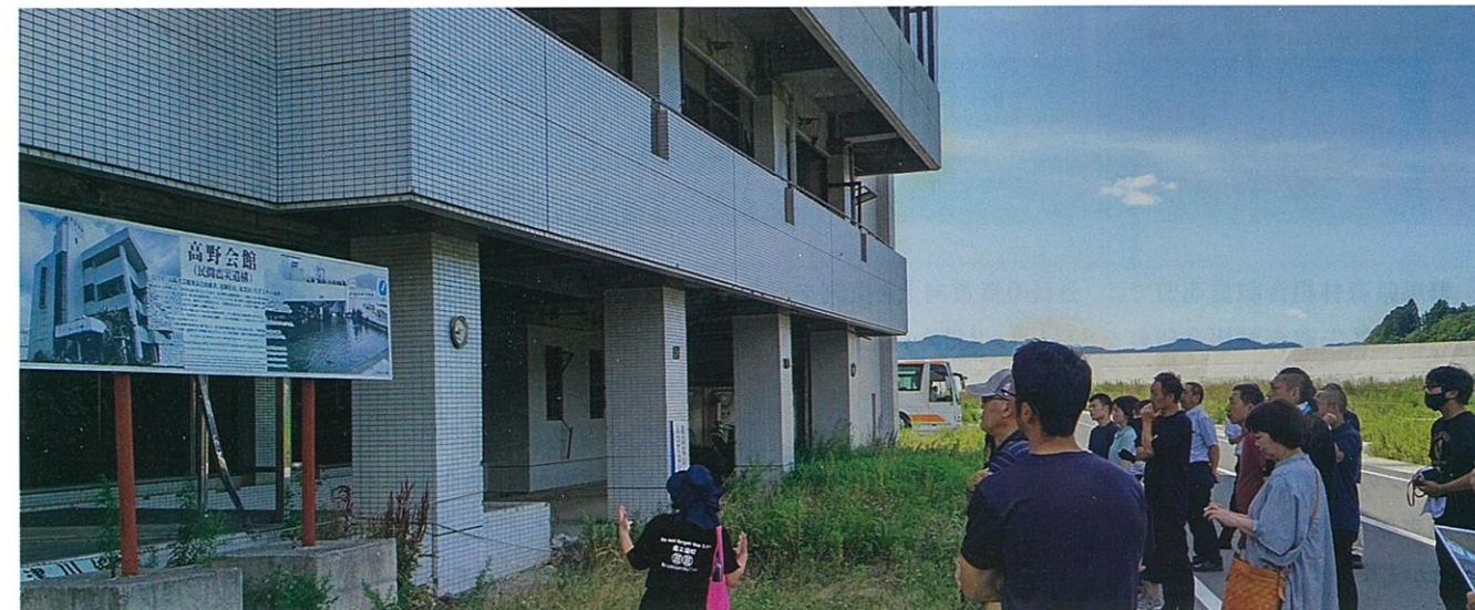
▲被災施設(震災遺構)見学
